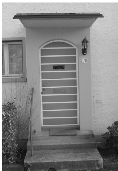
In bestehender Tür integriert (von der Post so nicht mehr akzeptiert)
