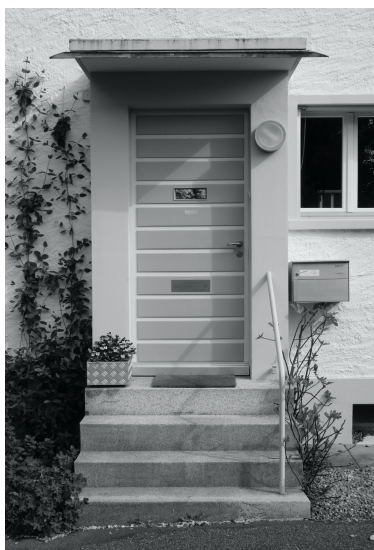
Neuer Briefkasten neben Eingangstür auf Seite Fenster. Direkt unter dem Fenstersims montiert (Farbe Weiss oder Aluminium eloxiert)
